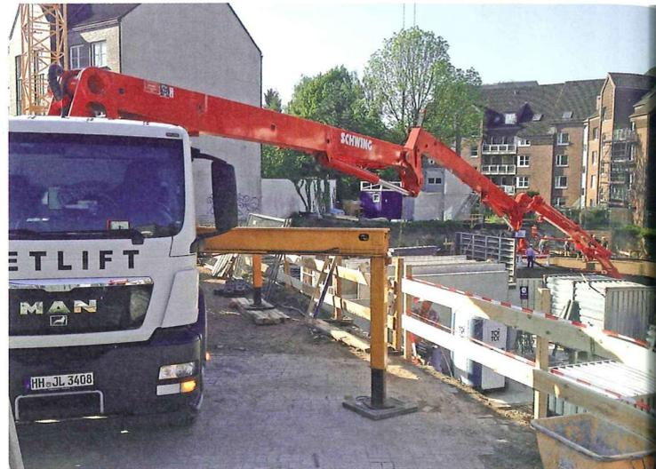
Betonpumpe als Rohrbrücke in die Baugrube, ganz im Hintergrund das Betonverteilermodul.
