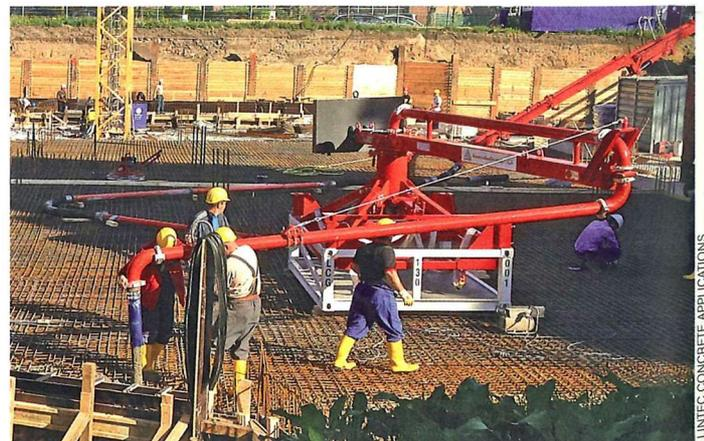
Betonverteilermodul VMR10.C1RT17 auf der Bewehrung, mit 3 400 kg GG auf 7,2 m<sup>2</sup>.
